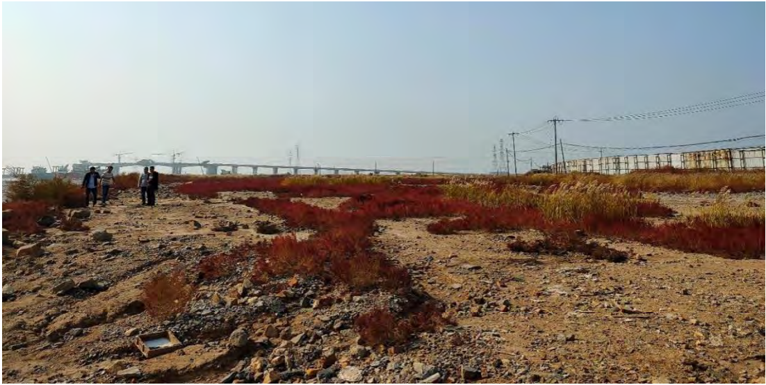
图 7.2-1 拟建雷达站场址现场情况
