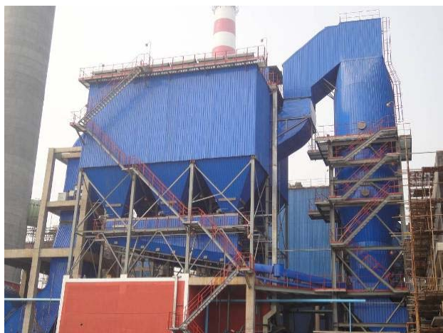
现场工程照片
